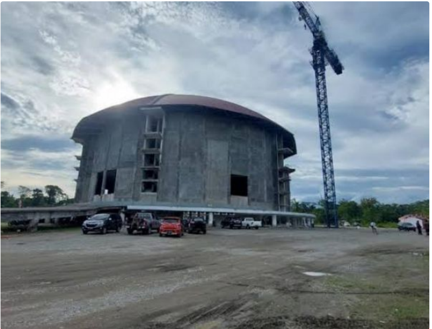
Pembangunan Gereja Kingmi Mile 32
